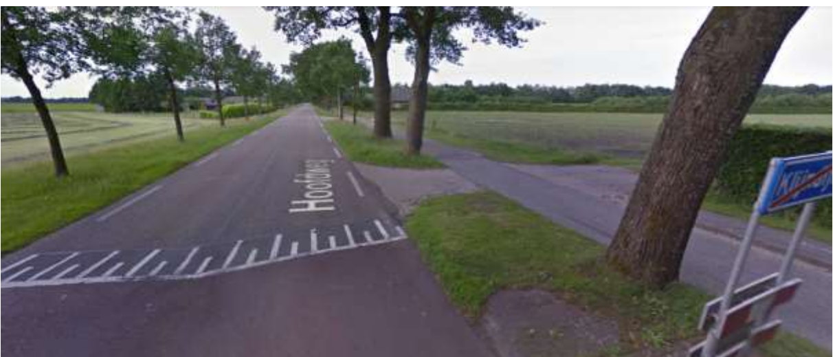
Verkeerde wegbelijning (3-3) op de Hoofdweg Klijndijk, buiten de bebouwde kom (bron: Google Maps)
