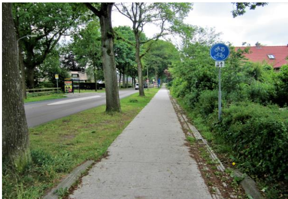
Foto 6: (brom-) fietspad in twee richtingen
